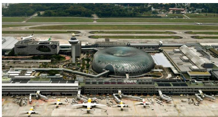
Figura 18: Centro de entretenimento e lazer do Aeroporto de Cingapura. Fonte: The Straits Times 21
