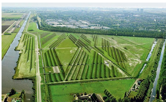
Figura 33: Barreiras naturais instaladas como barreira acústica. Fonte: Smithsonian Magazine 37
